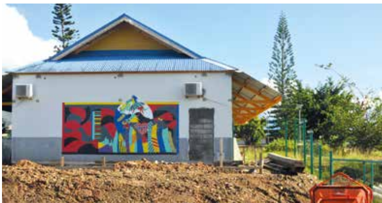
Le collège de Koné fait l'objet d'un important programme de travaux.
