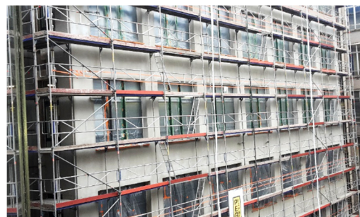
Remplacement des châssis et Isolation des façades
