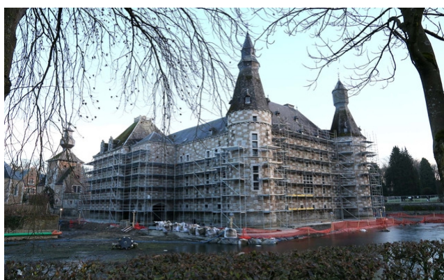
JEHAY - Placement d'un échafaudage en vue de la restauration
