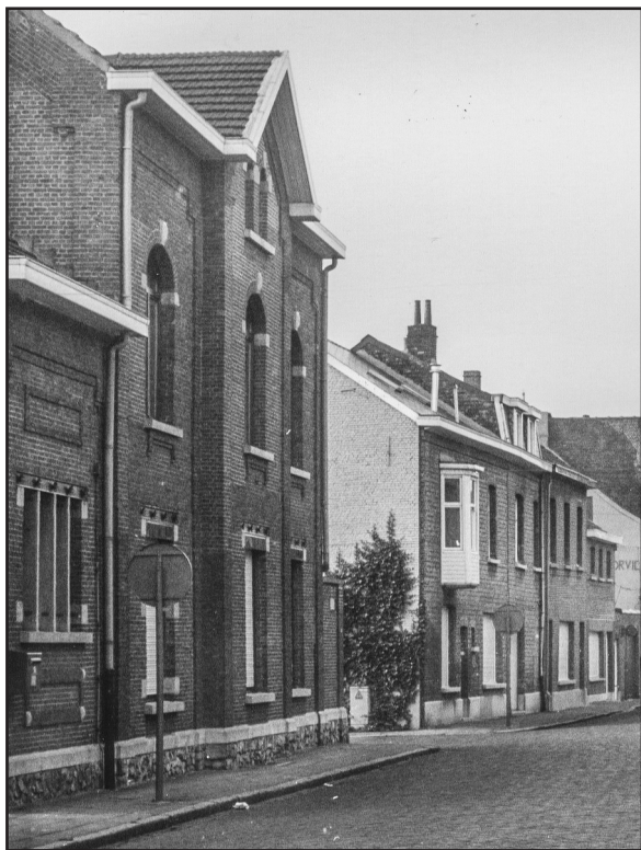
Drukkerij Verbruggen aan de Molenstraat (naast het station van de tram)
