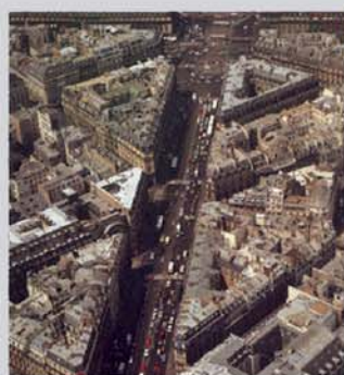
10- COUR EN ÎLOT, AVENUE DE L'OPÉRA, PARIS
