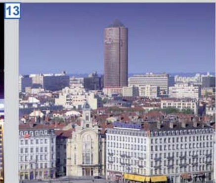
13- LA TOUR DE LA PART-DIEU, LYON, 1977, arch. : ARALDO COSSUTTA & ASSOCIATES
