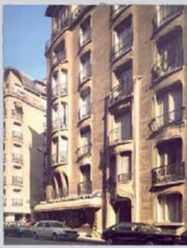
10- MAISON RUE SAINT-FERDINAND, PARIS, XIX e S. 11- ENTRÉE D'IMMEUBLE RUE LECONTE-DE-LISLE, PARIS, XIX e S. 12- IMMEUBLE RUE LA FONTAINE, PARIS, 1910-1911 arch. : GUIMARD
