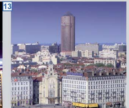
13- LA TOUR DE LA PART-DIEU, LYON, 1977, arch. : ARALDO COSSUTTA & ASSOCIATES
