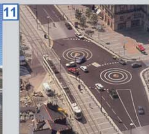
17 MINI-GIRATOIRE, COURS DES 50 OTAGES, NANTES, arch. : ROTA, FORTIER et BLOCH
