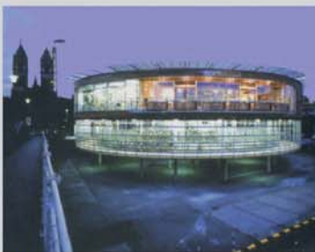
10 10- GARAGE À VÉLO GÉANT, FREIBURG-IM-BREISGAU, arch. : HOTZ + ARCHITEKTEN
