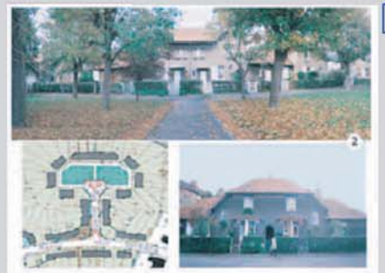
9- LES CLOSES DE LA CITE JARDIN DE STAINS, arch.: GONNOT et ALBENQUE
