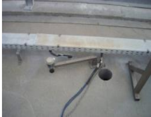
Figuur 2: Voorbeeld van een overvulsensor.
