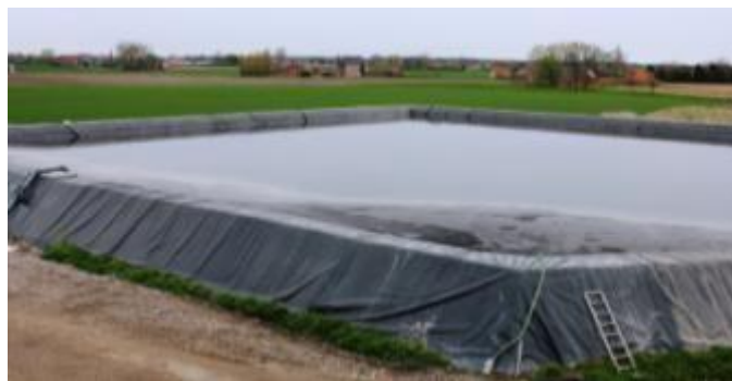
Figuur 4: Effluentbekken met folie over buitentalud.
