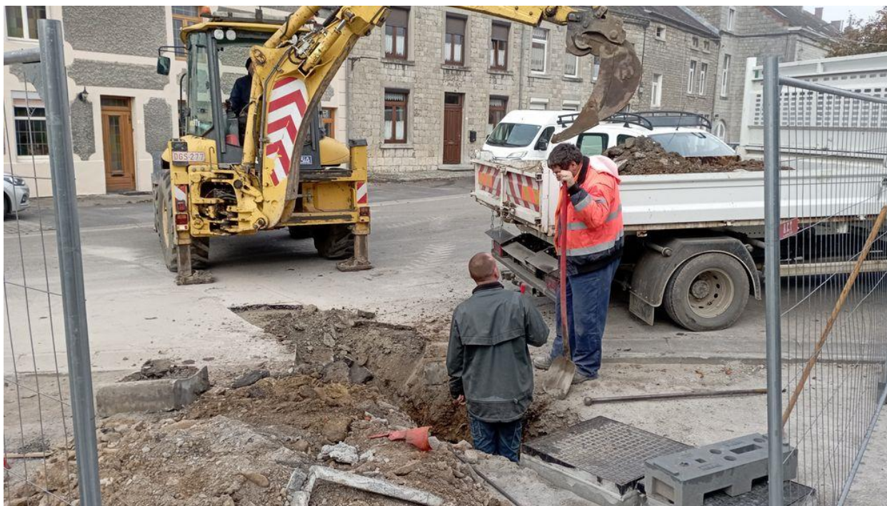
Branchement à l'égouttage de la MJ rue Longue à Nismes
