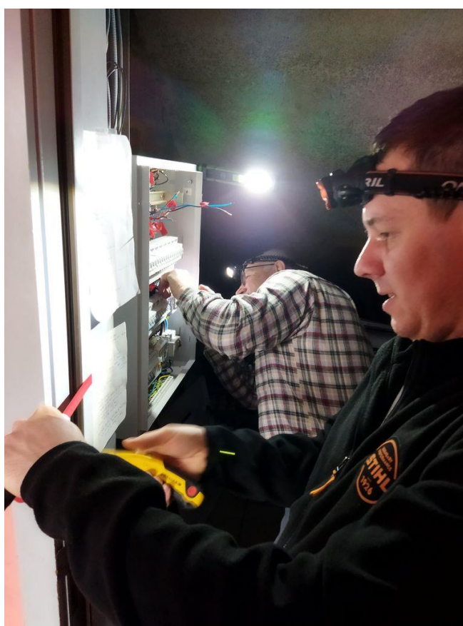
Mise en conformité électrique de la cafétaria de l'EAM à Treignes
