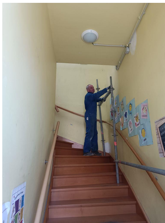
Travaux de peinture à l'école de Vierres
