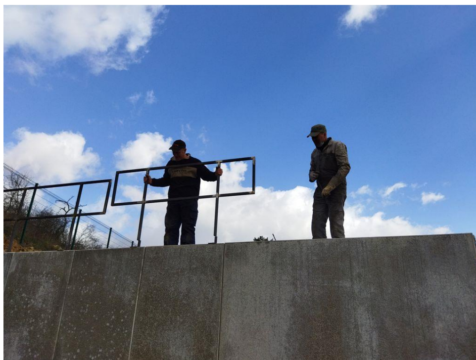
Fabrication et placement de garde-corps
