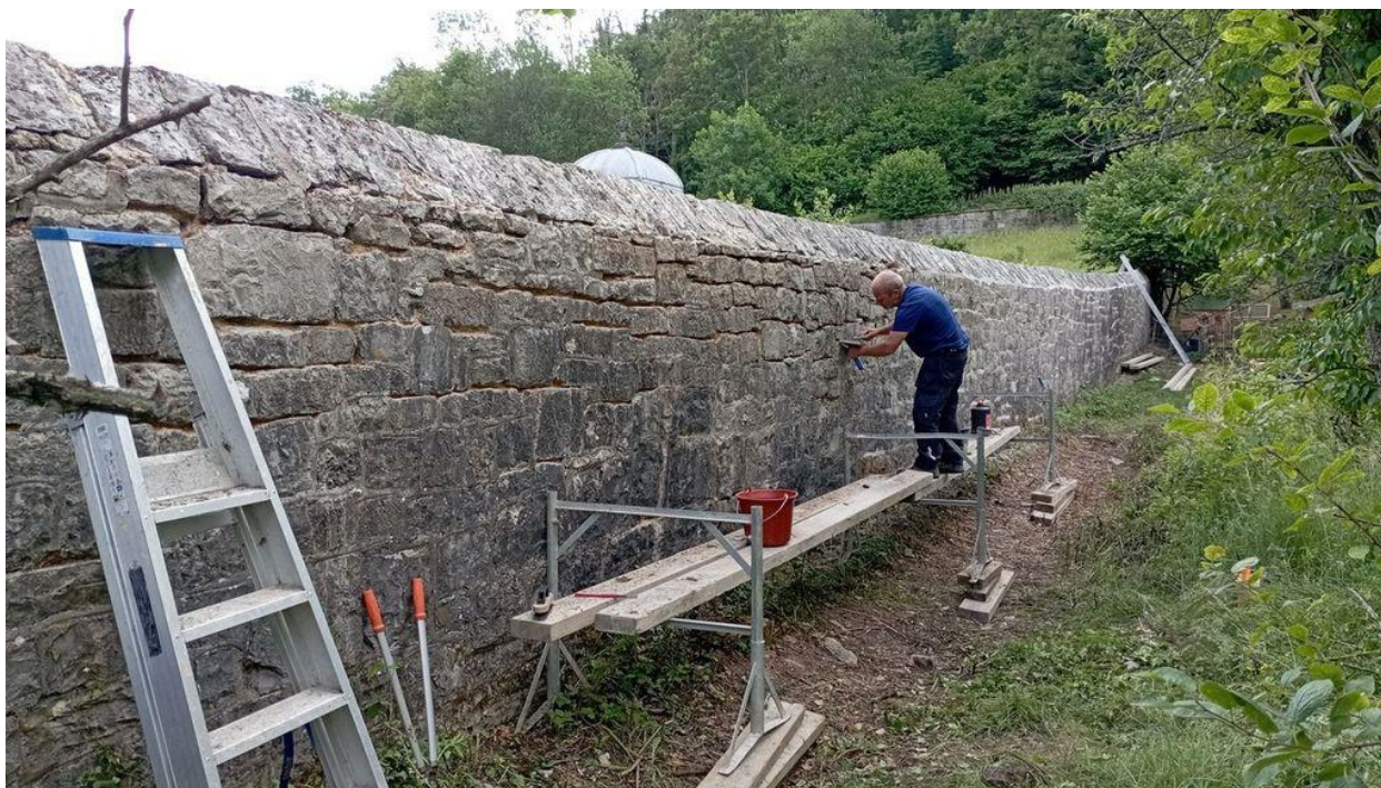
Rénovation d'une partie des murs du cimetière de Nismes – Ainseveau
