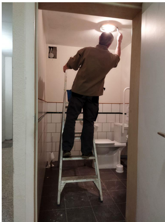
Travaux de plafonnage et peinture dans le couloir de la salle Patria à Olloy
