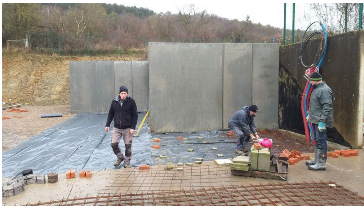
Aménagement pour la mise en place de conteneurs au hall technique à Vierves
