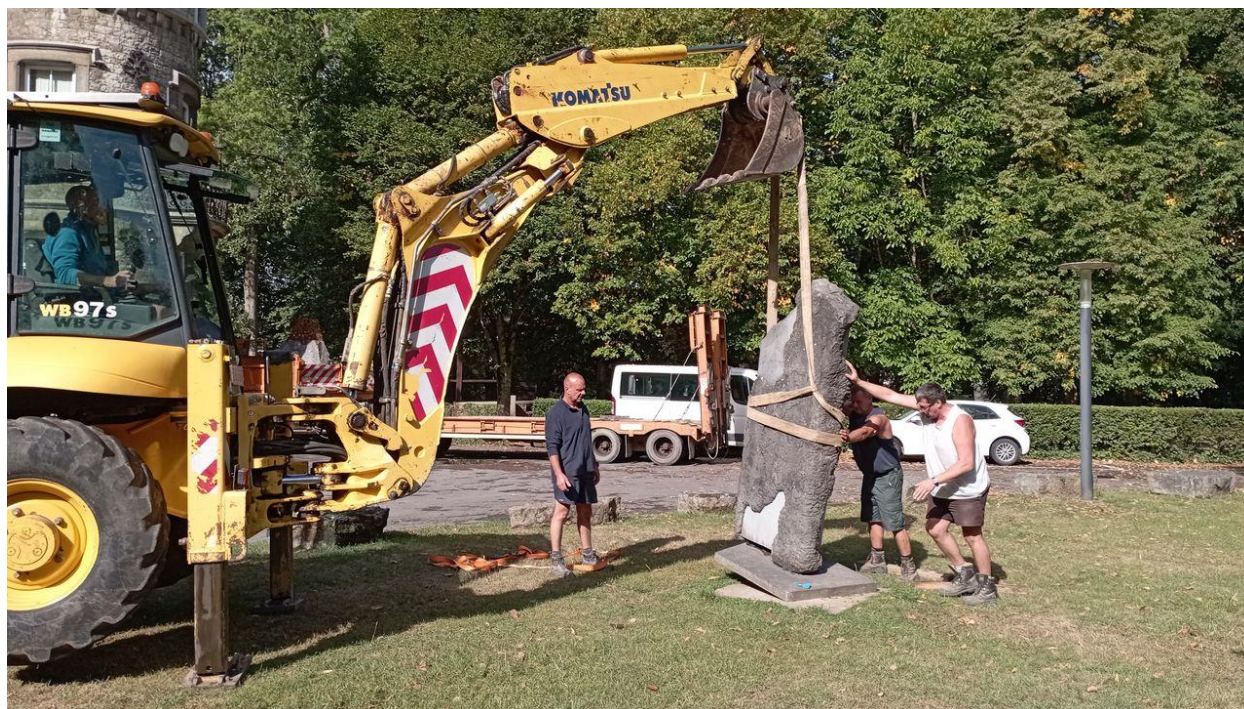
Mise en place des sculptures dans le Parc de Nismes
