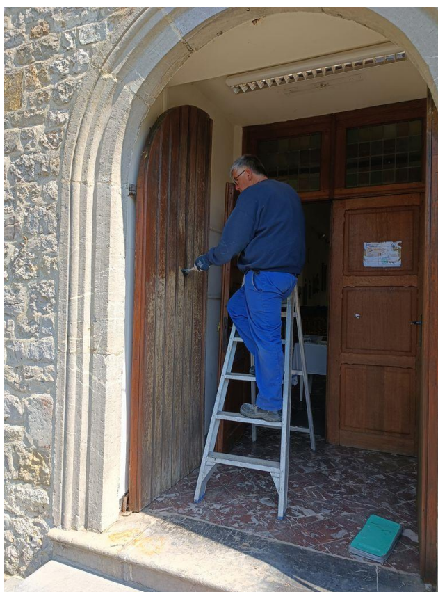
Rénovation de la porte d'entrée de l'église de Douibes
