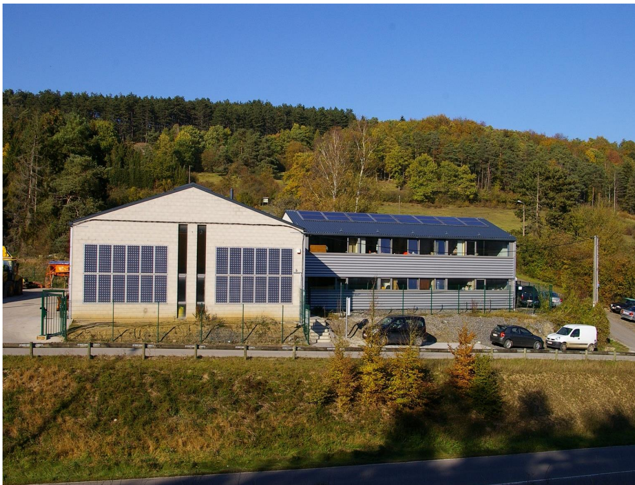
Le Service des Travaux à Vierves
