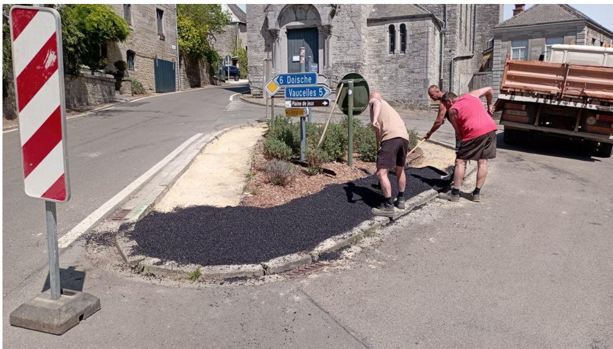
Réfection de l'îlot rue Arthur Masson à Mazée
