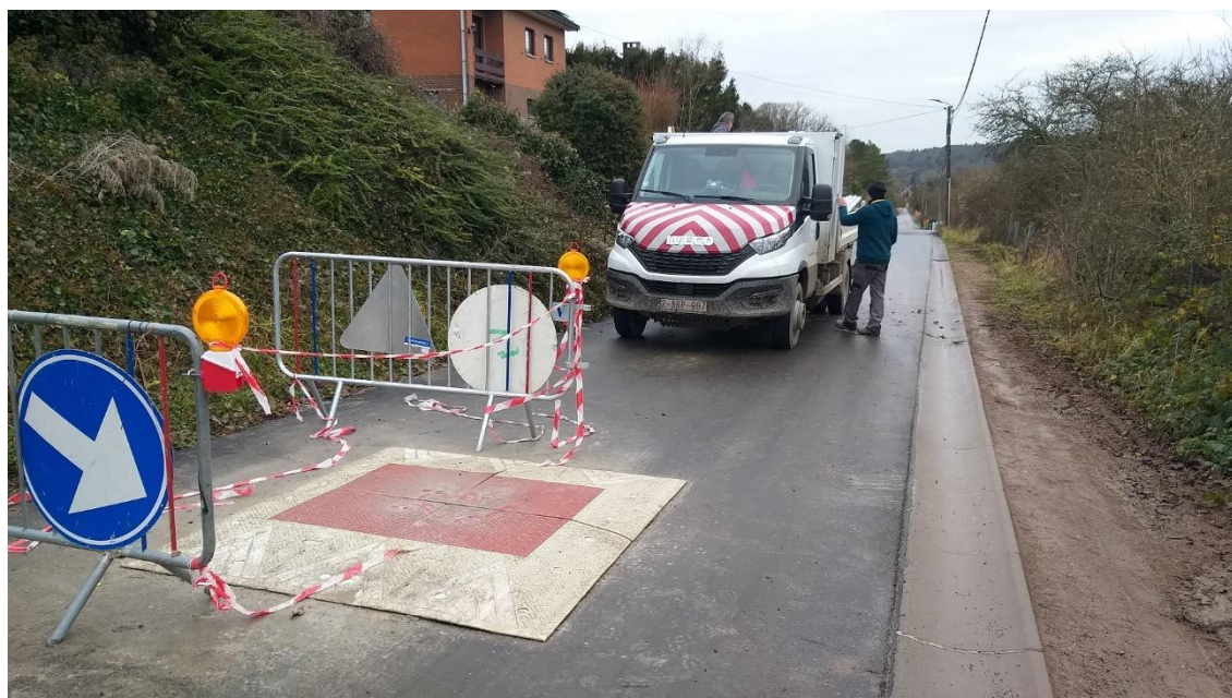
Mise en place des coussins Berlinois rue Ainseveau à Nismes
