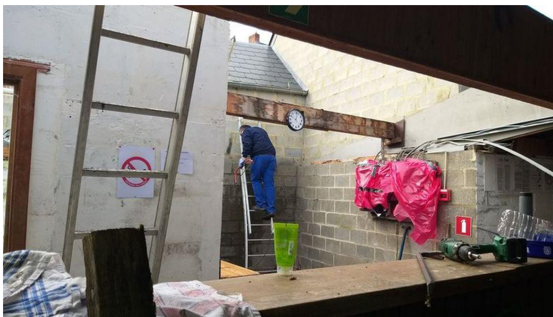
Remplacement de la toiture du bar + peinture à la salle Dothorpa à Dourbes
