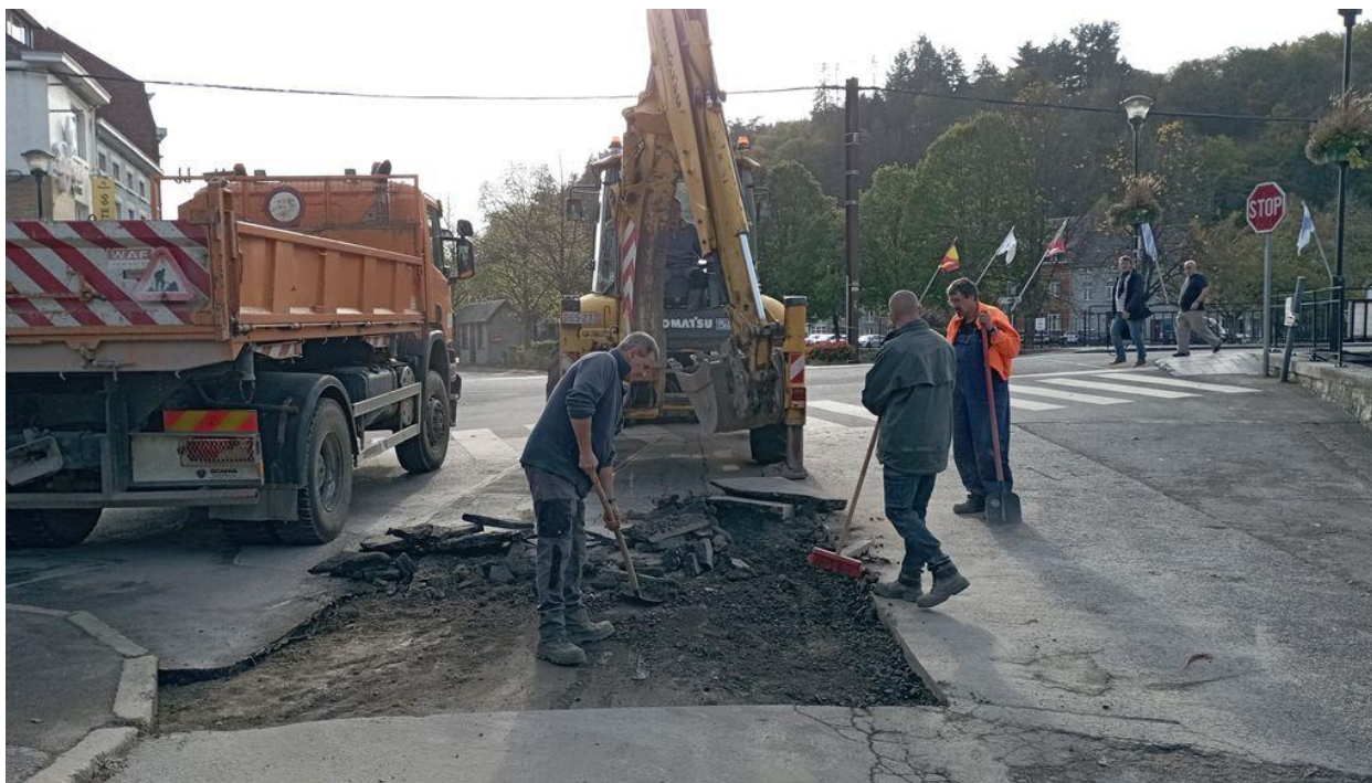
Stabilisation taque d'égout + asphalte à l'entrée du parc de Nismes
