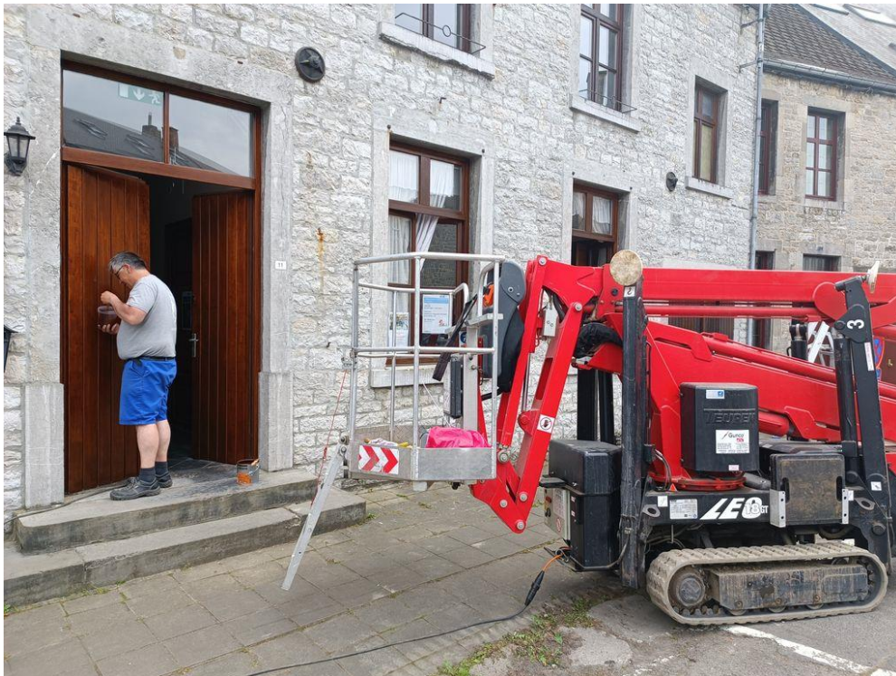
Traitement des châssis de l'ancien Presbytère de Nismes
