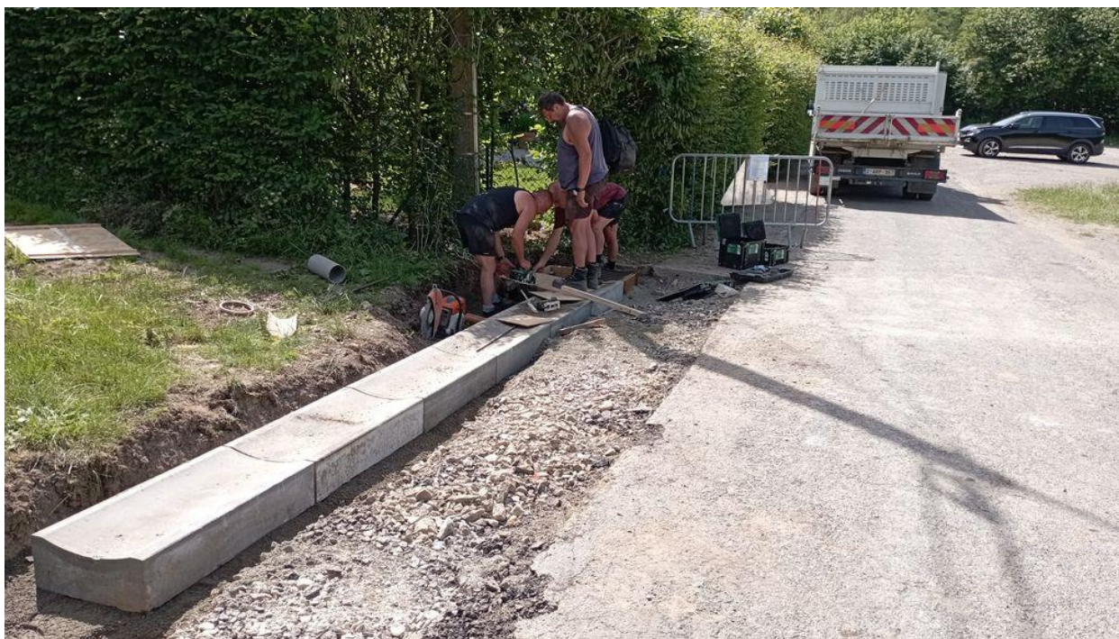
Mise en place de filets d'eau rue de Fays à Douibes
