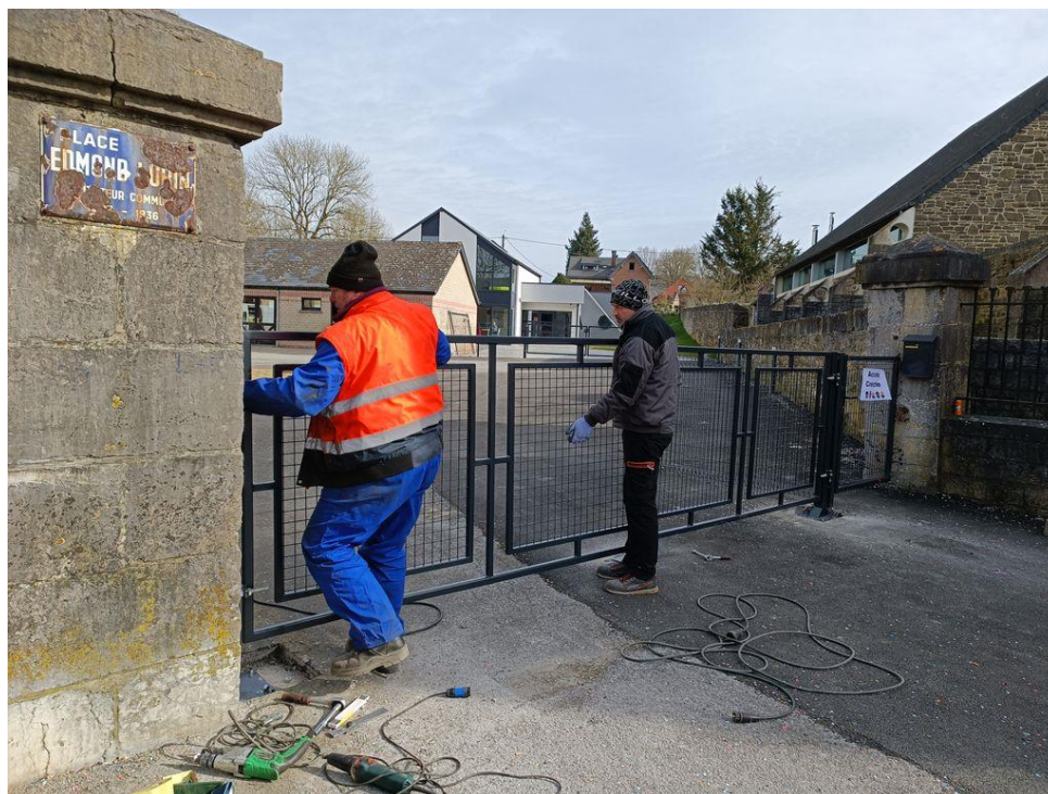
Création et remplacement de la barrière de la cour d'école d'Olloy
