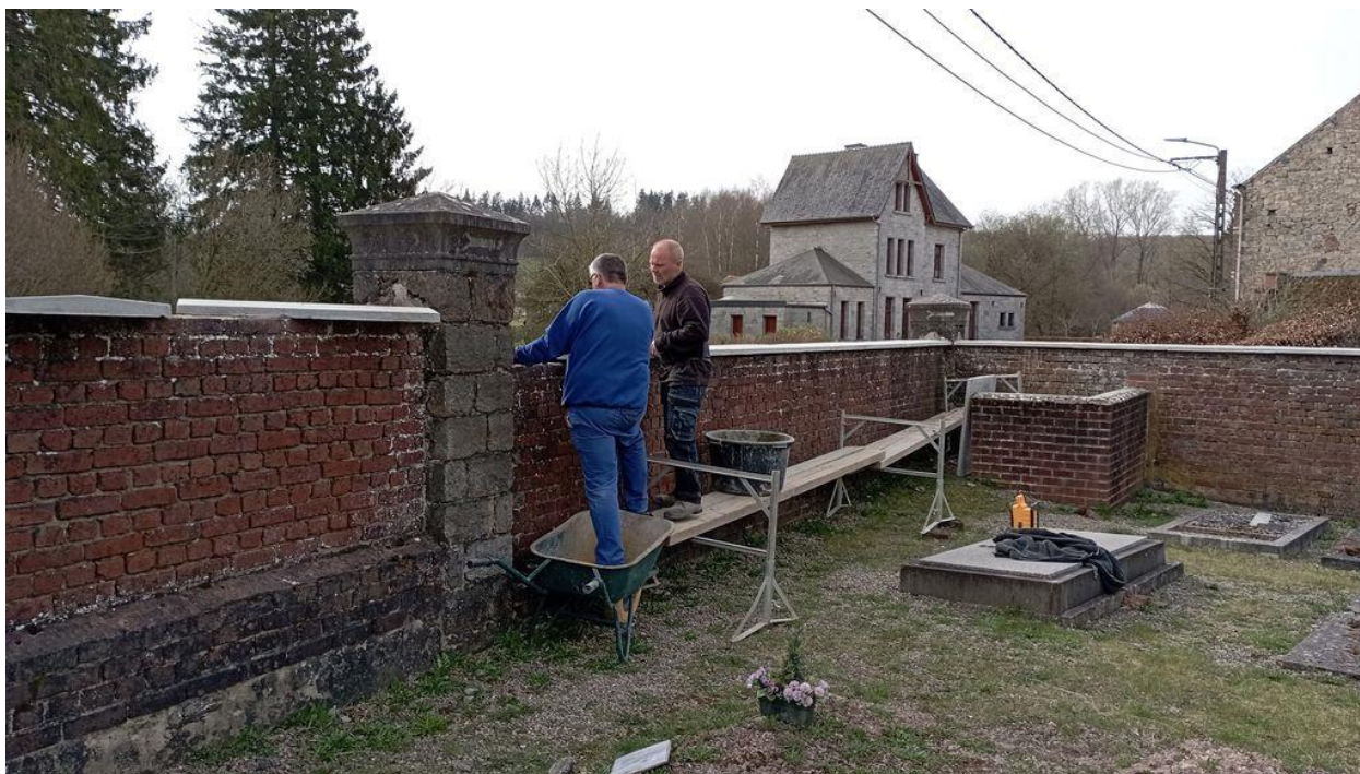
Rénovation d'une partie des murs du cimetière de Oignies
