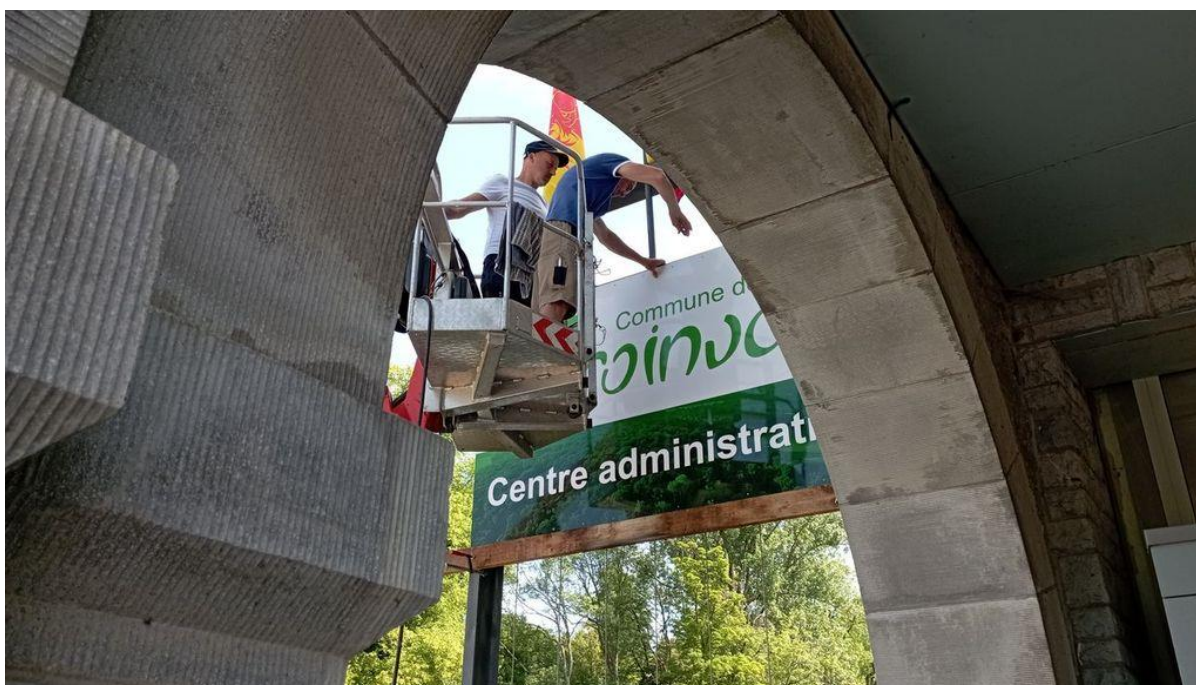
Placement du panneau « Viroinval » au Centre Administratif de Nismes
