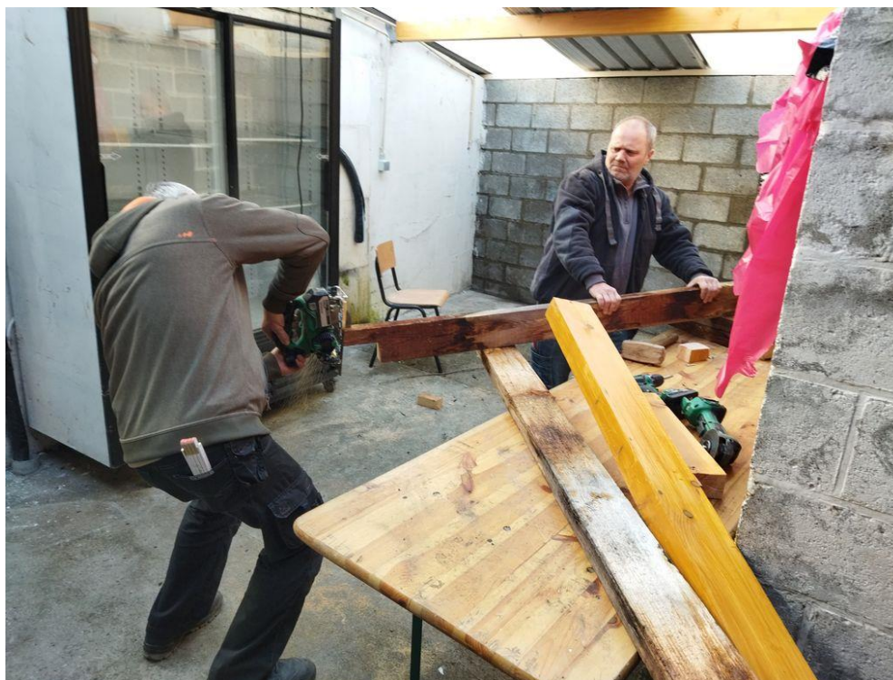
Remplacement de la toiture du bar + peinture à la salle Dotherpa à Douibes
