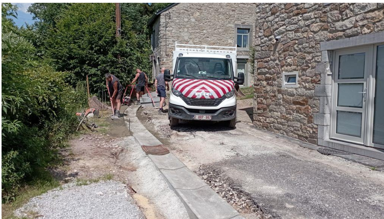
Réfection rue Petite à Oignies
