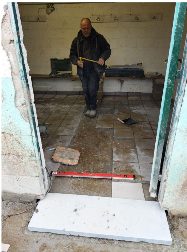
Rénovation des vestiaires + buvette du football d'Olloy (peinture, carrelage, châssis, ...)
