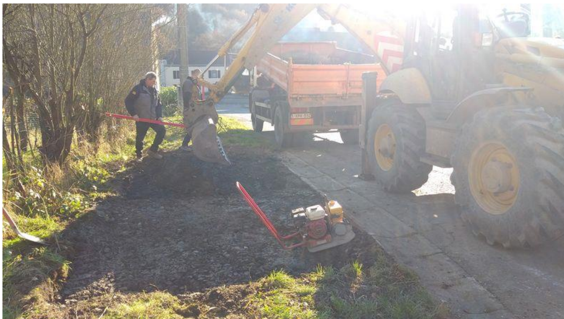
Terrassement bulles à verres à Najauge
