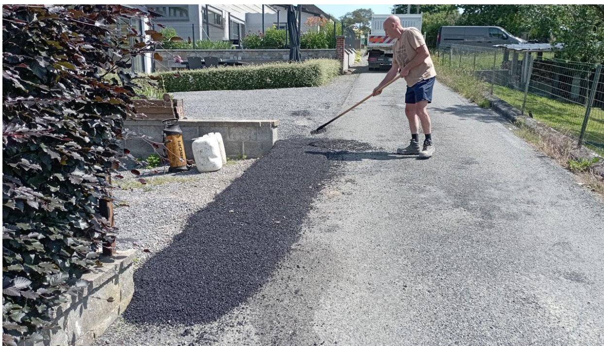
Travaux de voirie rue de Vaucelles à Mazée
