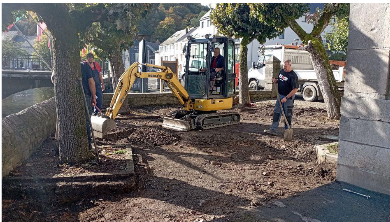
Réfection asphalte du parvis de l'église de Nismes
