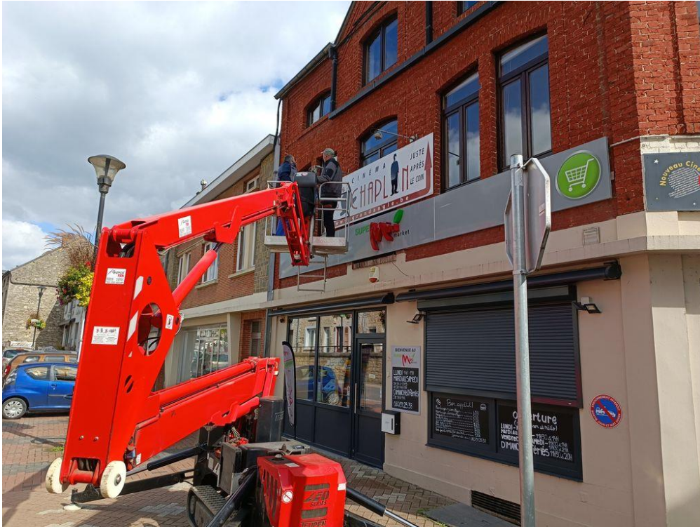
Aide au remplacement de l'éclairage extérieur + traitement des châssis du Cinéma Chaplin de Nismes
