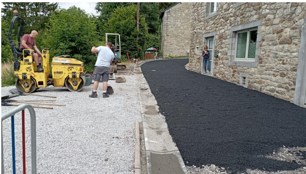
Réfection rue Petite à Oignies
