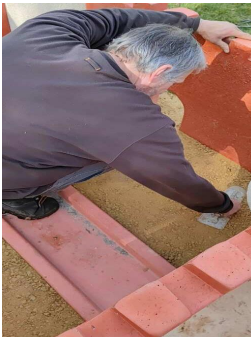
Pose de dolomie au mini-golf du parc de Nismes
