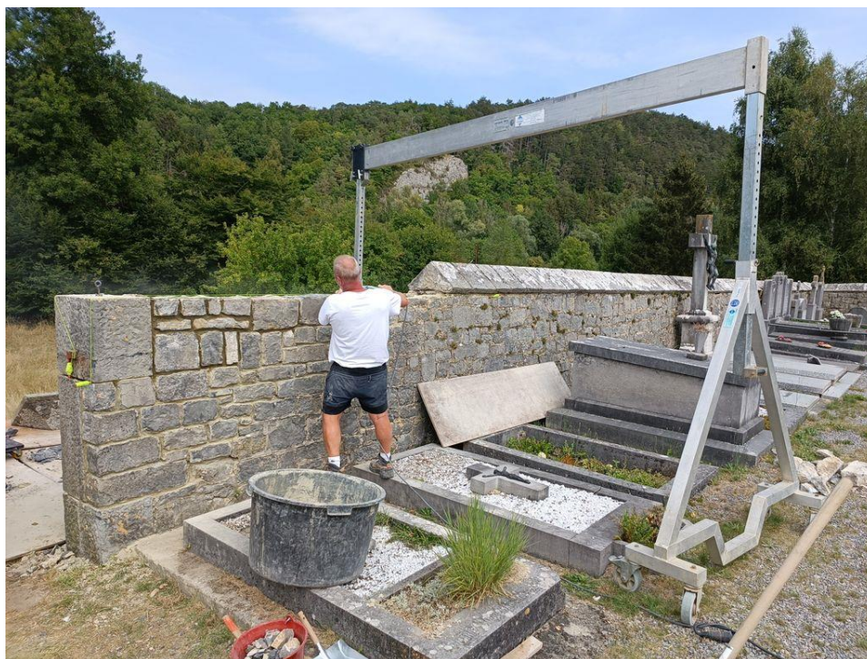
Rénovation d'une partie des murs du cimetière d'Olloy
