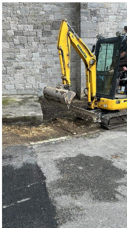
Assainissement de l'ancien site des bulles « Terre à l'église de Treignes
