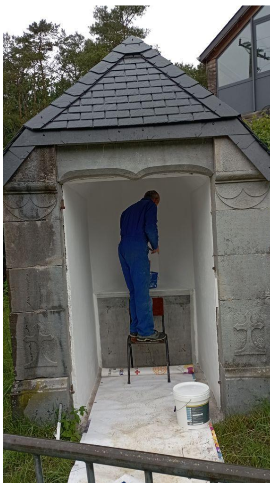
Rénovation de la porte + peinture de la chapelle à cote du Relais Verlainé à Vierves
