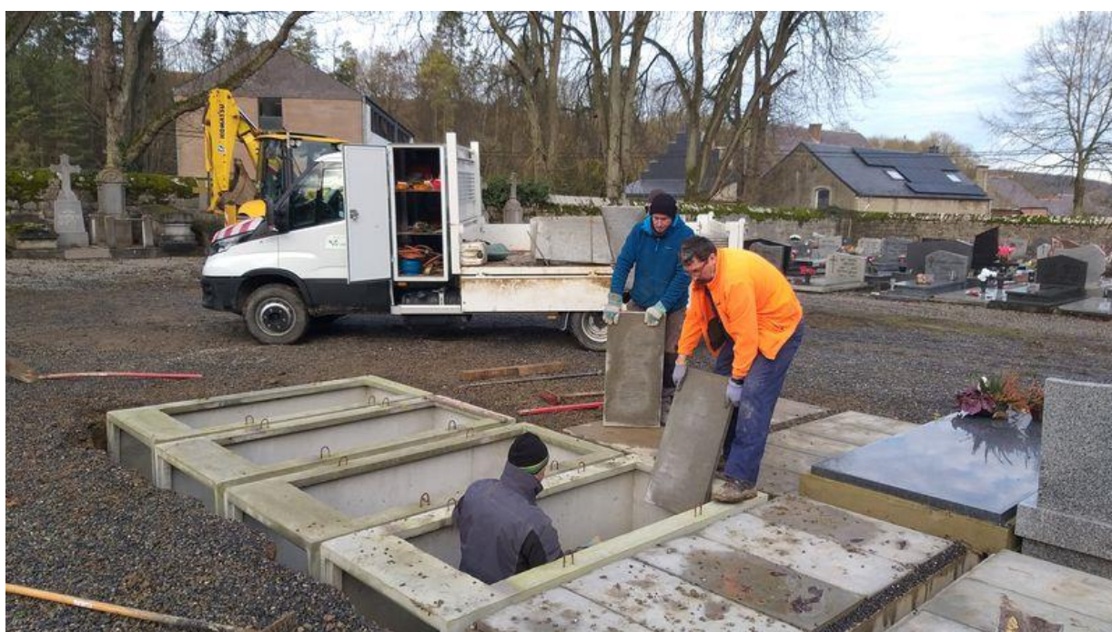
Mise en place de caveaux dans le cimetière de Nismes – Ainseveau
