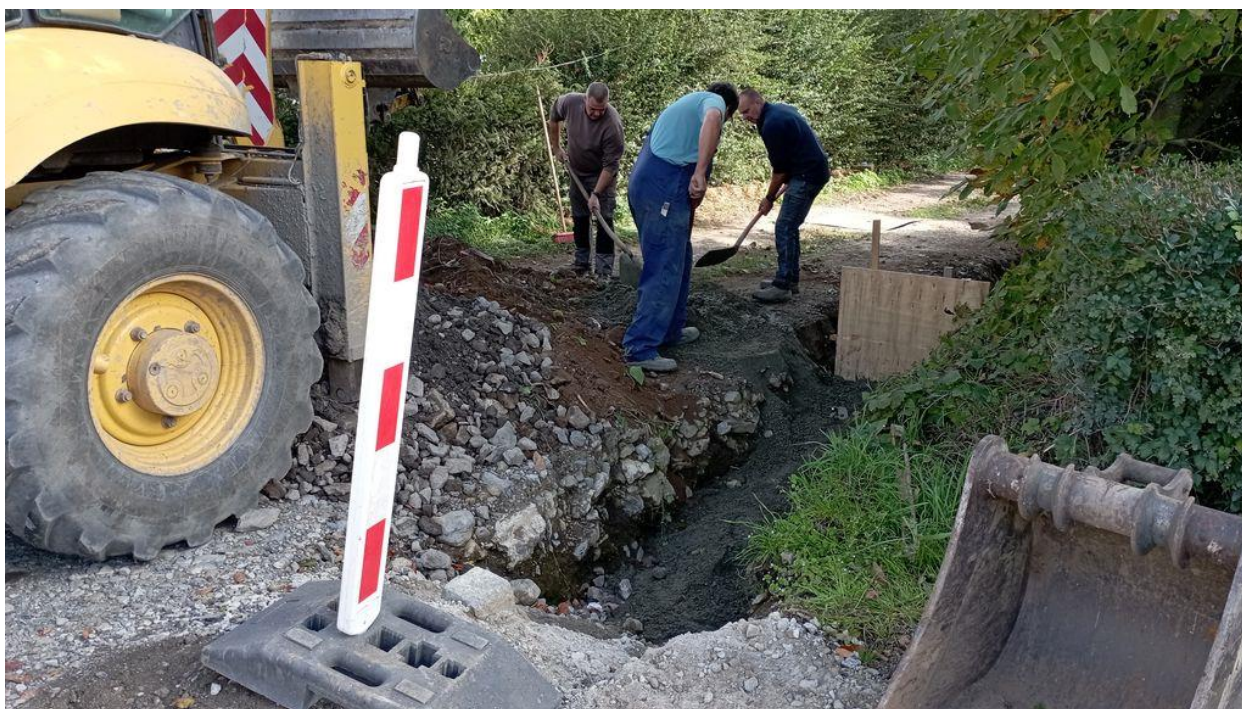
Création d'une tête d'aqueduc rue Albert Grégoire à Nismes
