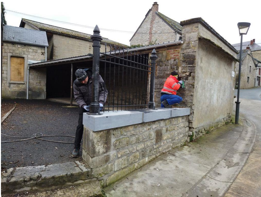
Rénovation et remise en place des barrières autour de la plaine de jeux de Dourbes
