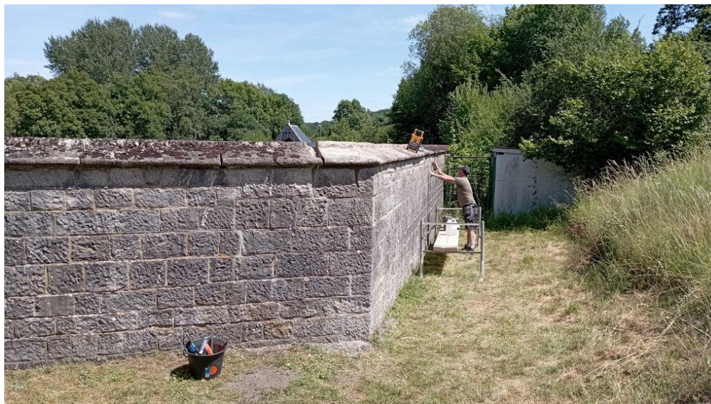
Rejointoyage des murs du cimetière de Treignes
