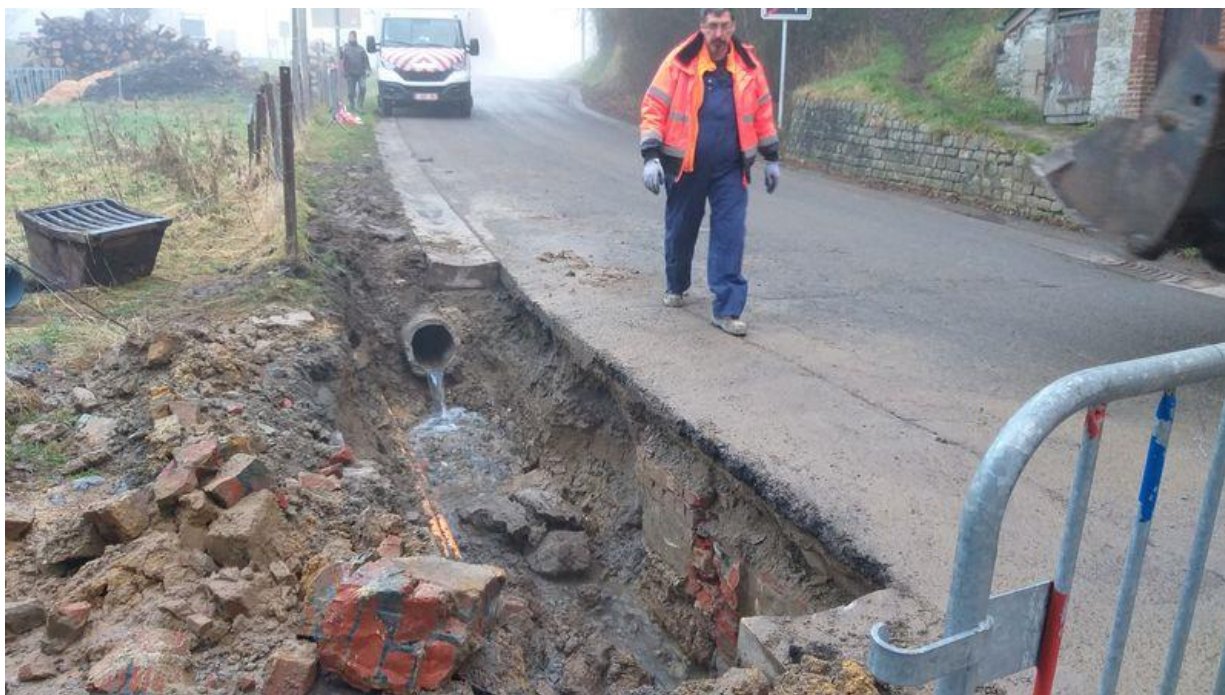
Réparation d'un égouttage rue de la Gendarmerie à Vierves
