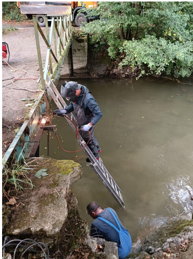
Stabilisation du pont surplombant le Viroin rue de Fays à Dourbes
