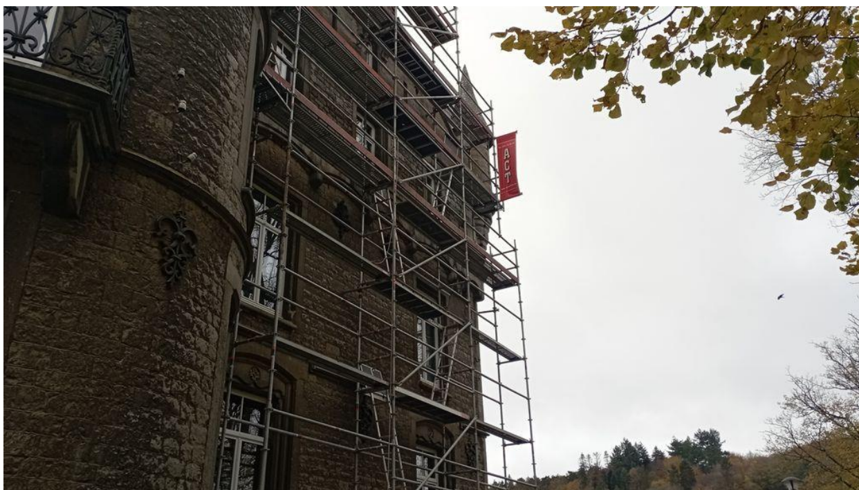
Rejointoyage d'un pignon du château communal de Nismes
