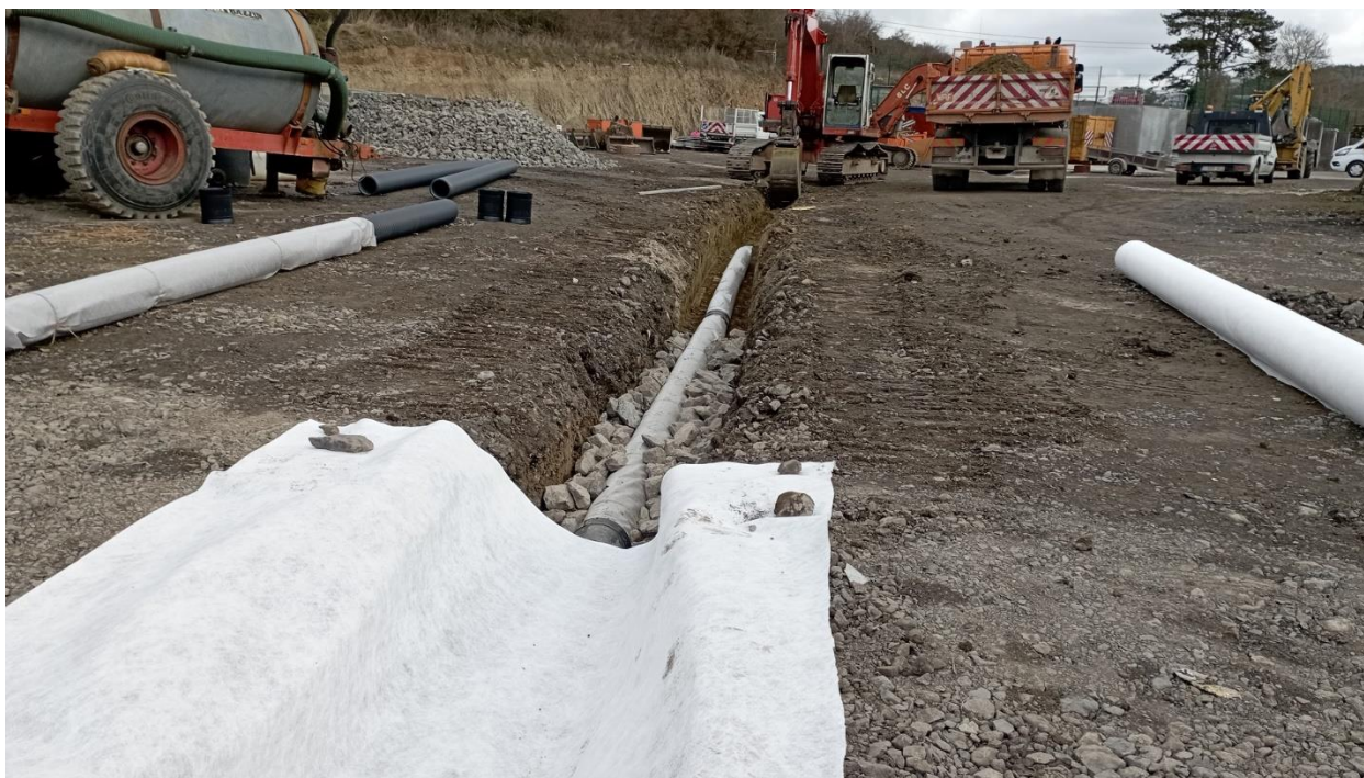
Mise en place d'un drain au hall technique à Vierves
