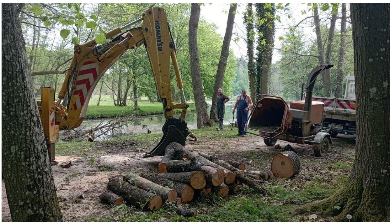
Travaux d'abattage dans le parc de Nismes
