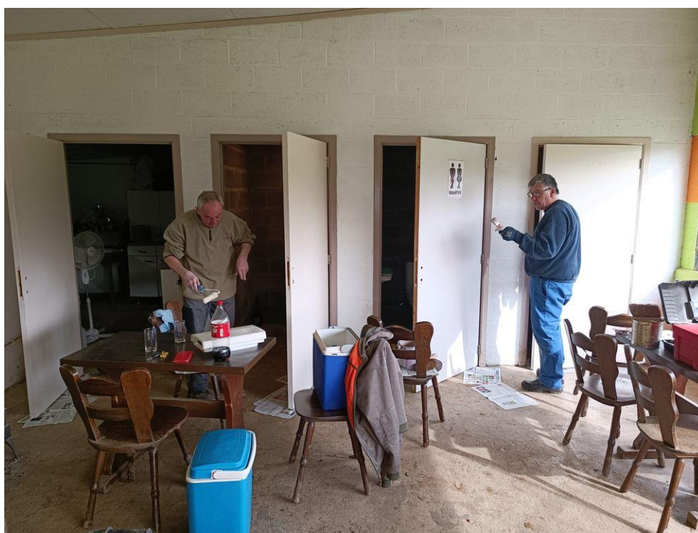
Rénovation des vestiaires + buvette du football d'Olloy (peinture, carrelage, châssis, ...)
