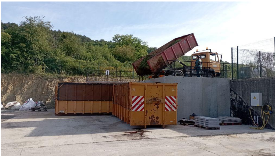
Amélioration du système de vidange containers au hall technique à Vervies
