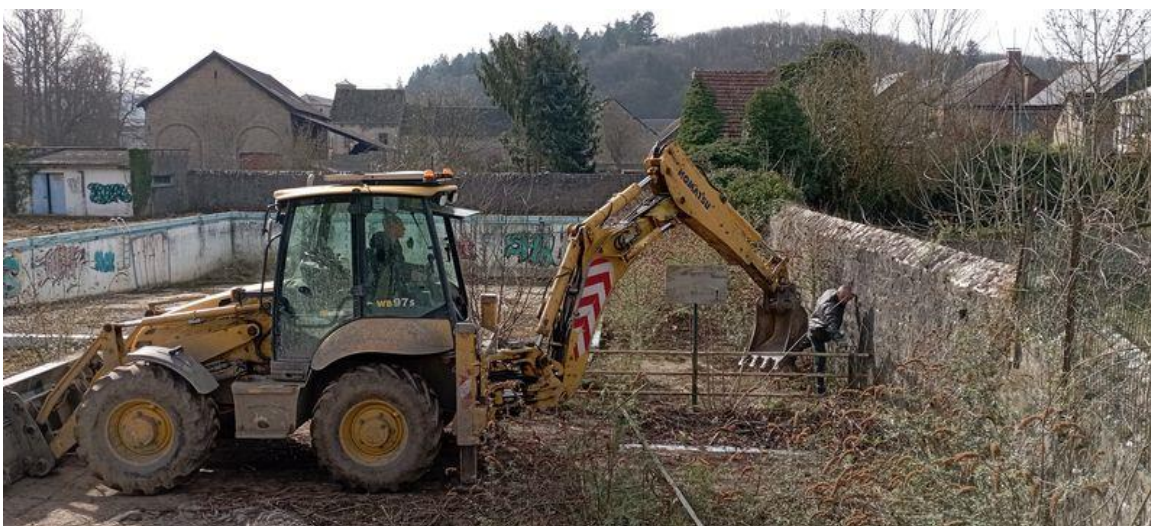
Assainissement du site de l'ancienne piscine à Nismes
