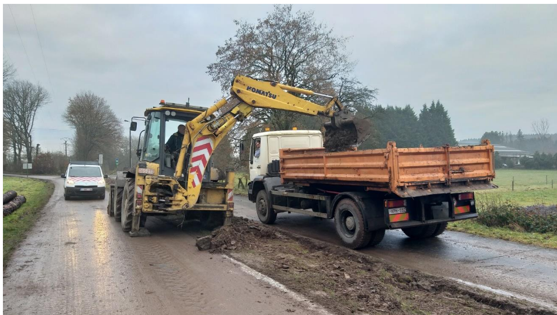
Terrassement en vue de la plantation d'une haie le long du Ravel à Oignies
