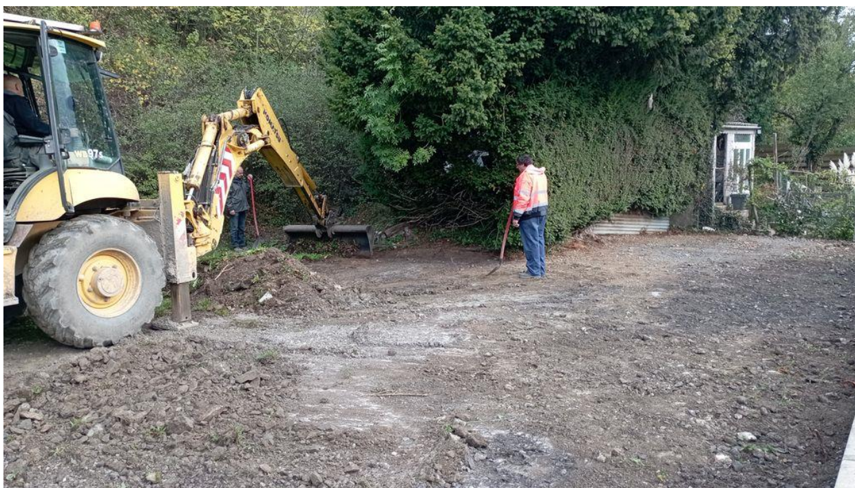
Aménagement du parking de la Maison de Repos à Nismes
