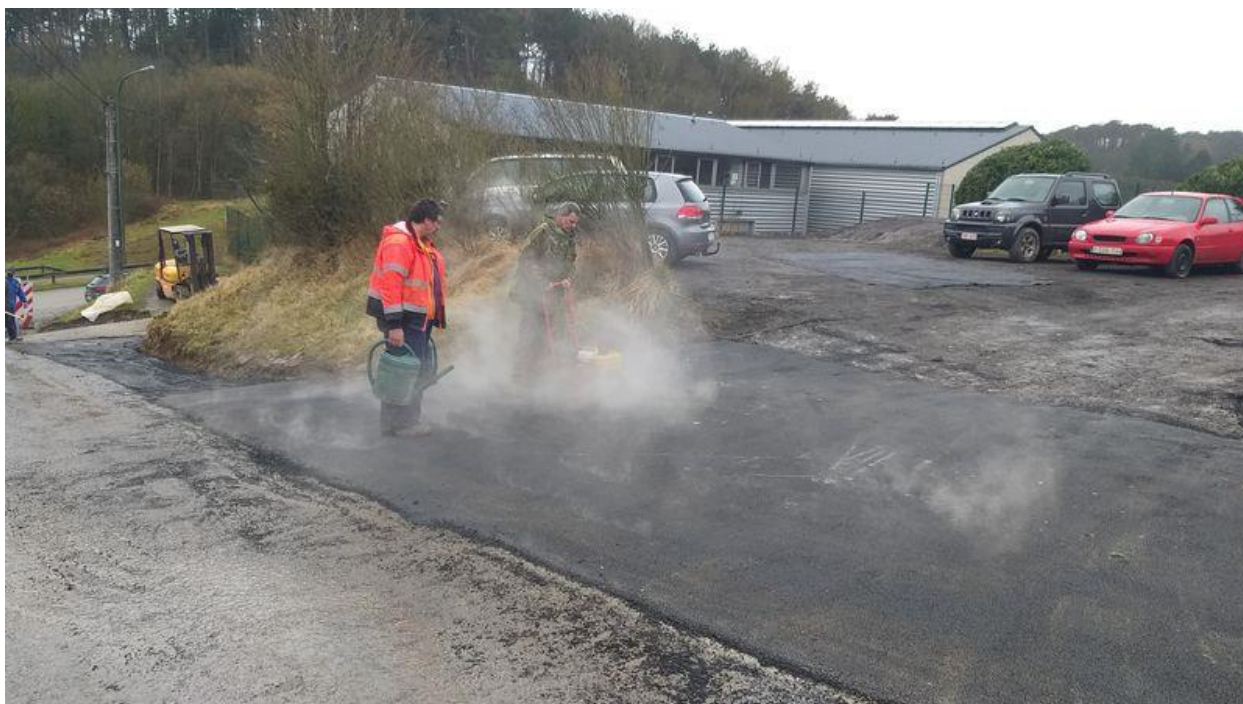
Réfection des accès au hall technique à Vierves
