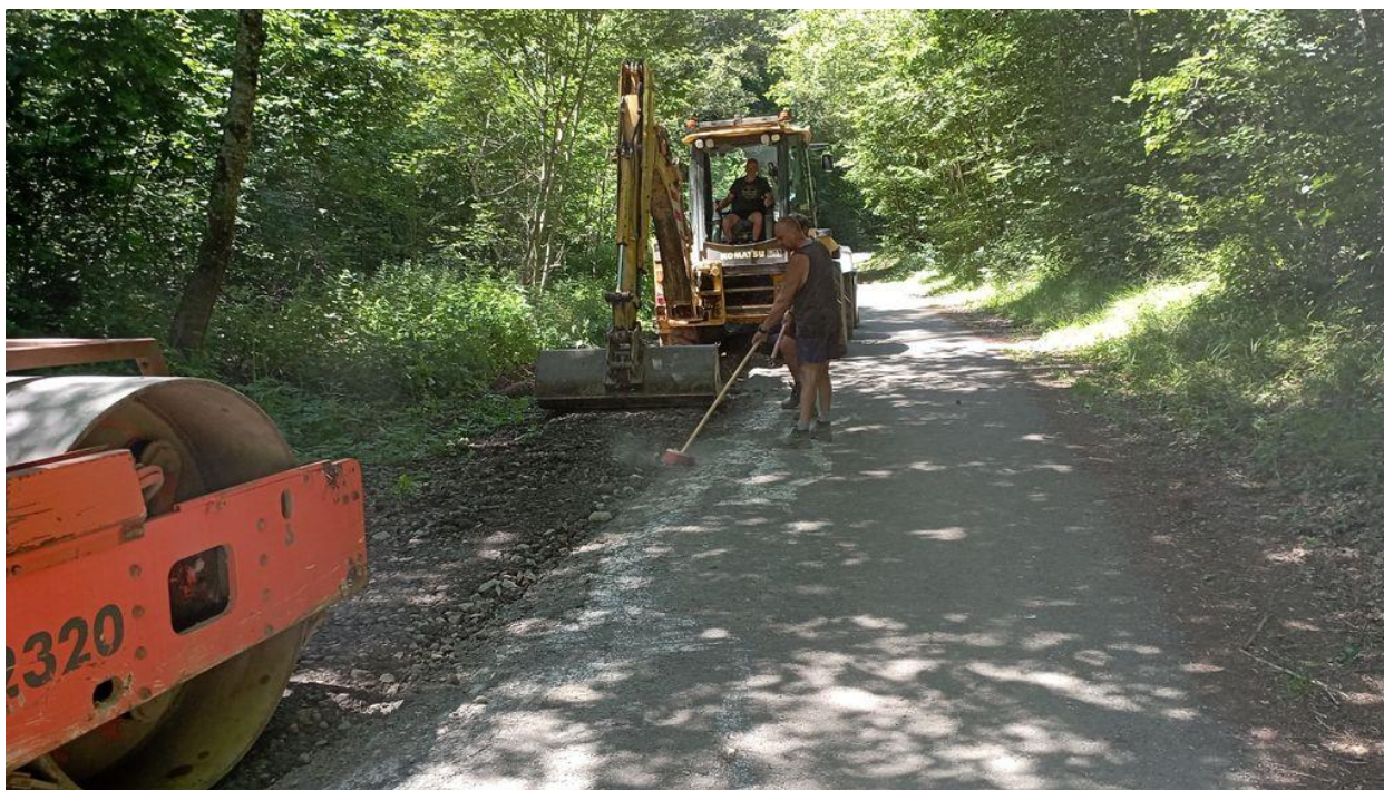
Stabilisation des accotements rue du Centre Physique à Dourbes
