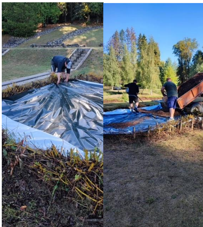
Assainissement des carrés potager dans le Parc de Nismes
