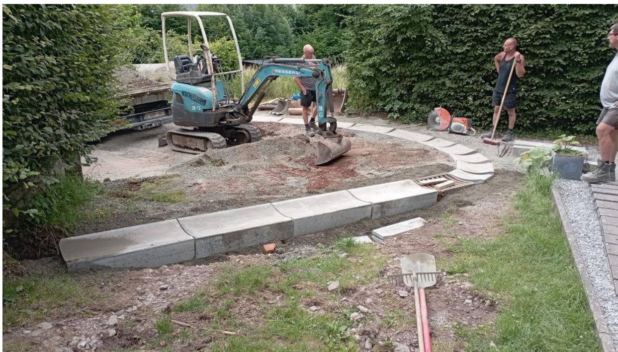
Réfection rue Petite à Oignies
