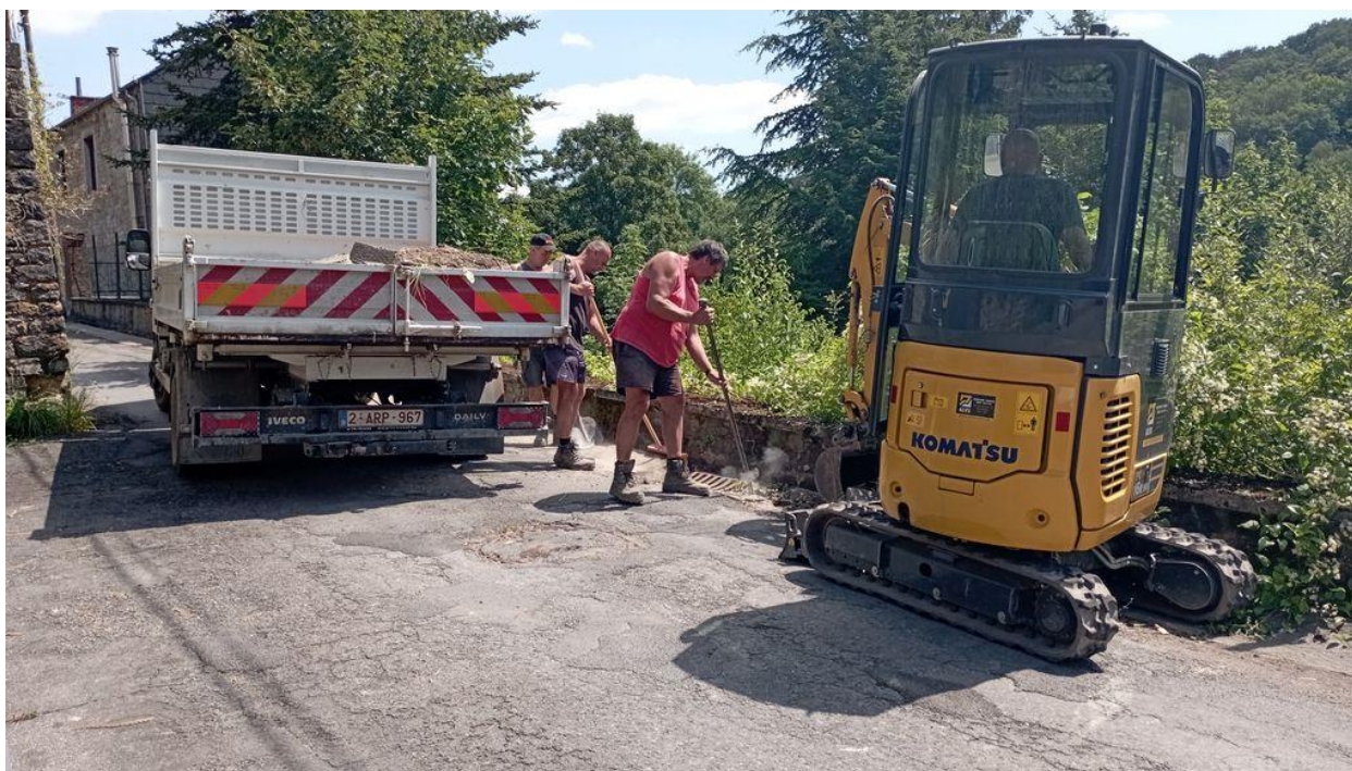
Cimentage et asphaltage des bords de voirie rue du Pont à Vierves
