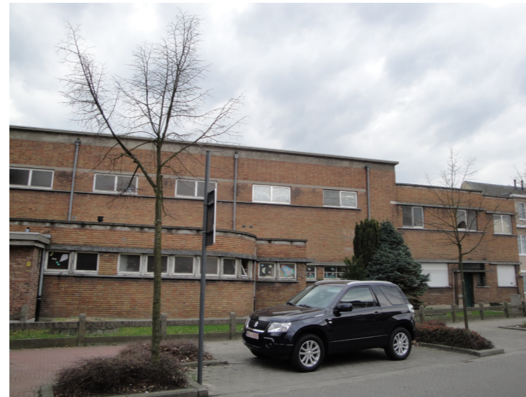
foto 2, voorgevel bestaande bebouwing met kloosterwoning
