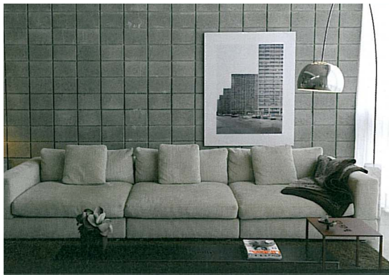
referentiefoto, vloer polybeton & wanden betonblokken
