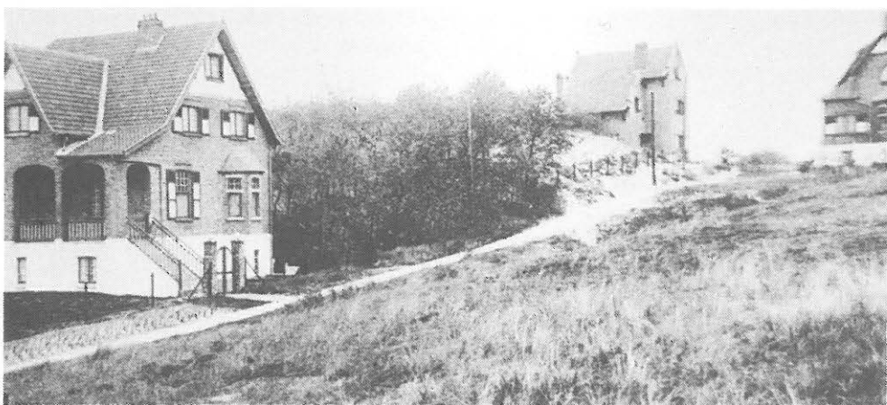
In het pasgeboren Zoute de kolonisatie van de duinen.
