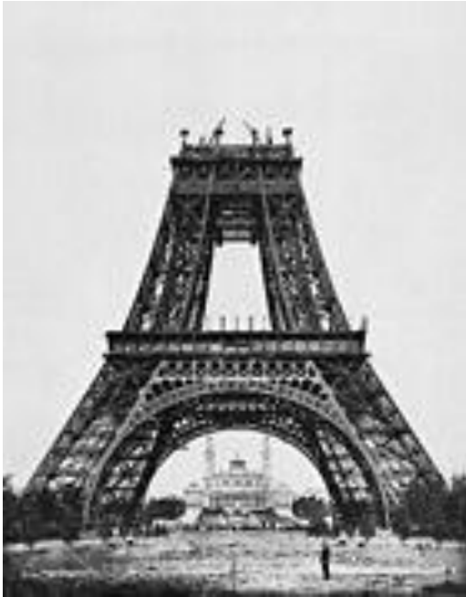
21 août 1888 : montage de la deuxième plate-forme
