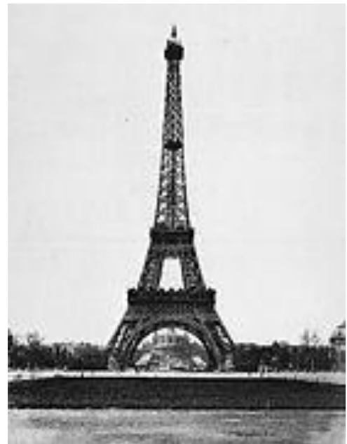
Fin mars 1889 : vue générale de l'ouvrage achevé
